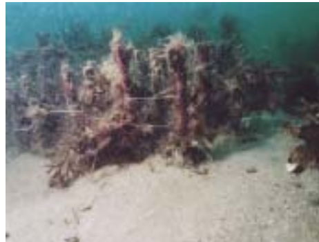
写真4 1991年に穴喰町穴喰港前に設置された人工産卵礁鉄筋タイプ(5cm間隔)。コンクリート部分は完全に砂に埋没し、鉄筋部分(長さ50cm)のうち最大で40cmが砂上に露出している。
