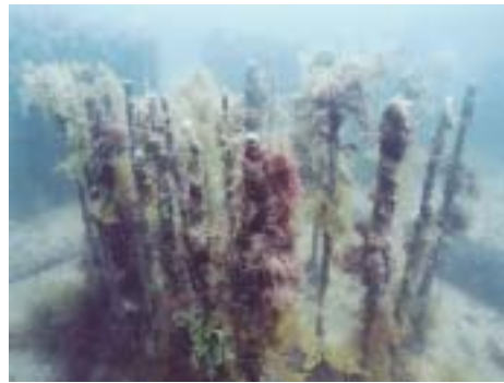
写真2 1990年に穴喰町小那佐湾に設置された人工産卵礁FRPタイプ。FRP棒(直径3mmと直径9mm)に付着物と海藻が付着している。一部のFRPは消失し、外被が剥がれ、FRPが露出しているものがみられる。
