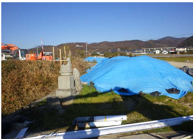
(1) 水田の表土を工事影響外に仮置
