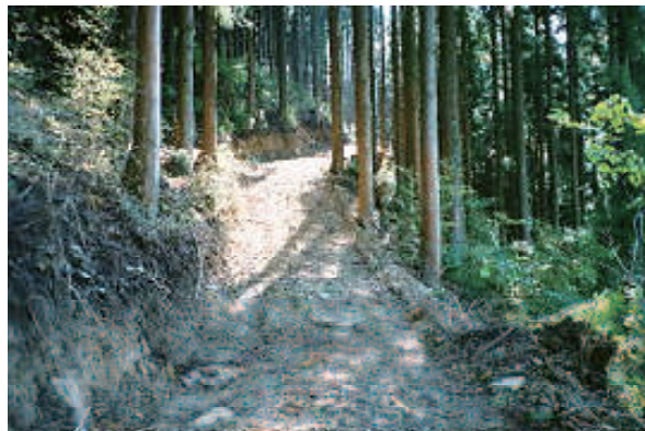
作業道の開設状況
