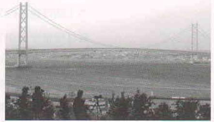
明石海峡大橋
