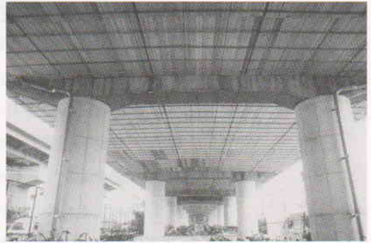
つり足場として高架橋の下面に敷き詰められる。 高速道路塗装工事に使用
