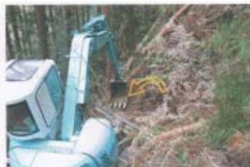
・表土を剥ぎ取り、床堀した上に積み上げ、転圧する。
