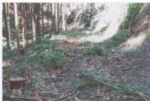
現地で発生した支障木を利用し、簡単に路肩の補強に利用することができます。路面の土砂流出防止のほか、車両走行時や高性能林業機械を据えたときの安全性が向上します。
