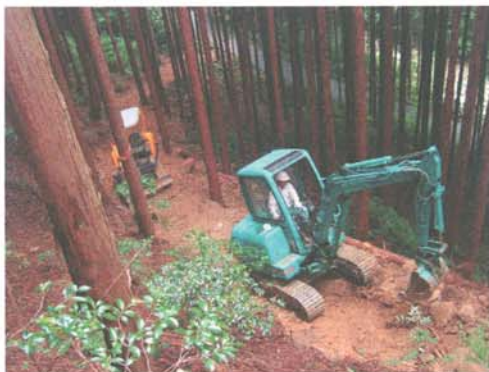
作業路の開設
