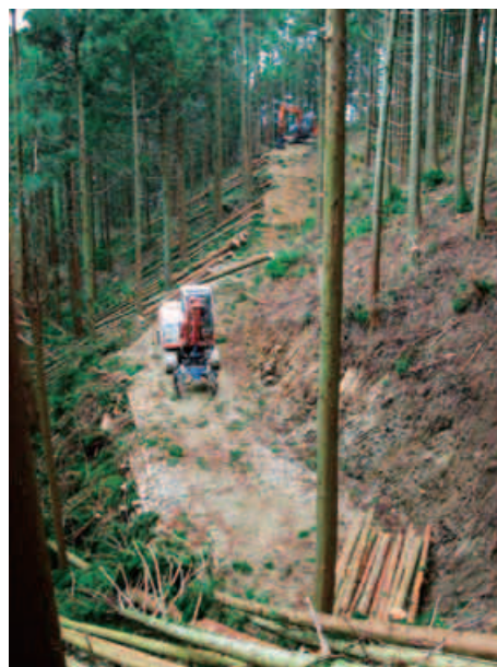
写真-4 伐倒木の処理状況
