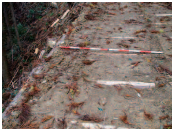
写真－2 作業路に支障木を敷設
