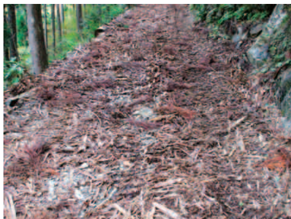
写真－3 木皮の敷設
