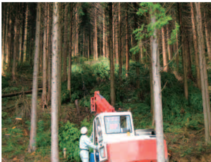
写真-2 下げ荷集材の運転操作
