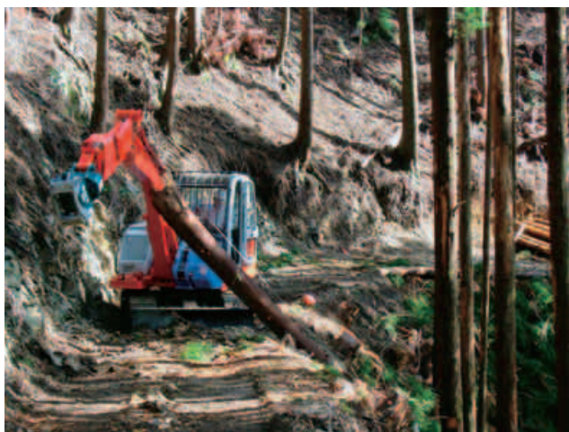
写真-1 安定的なスイングヤーダ設置
