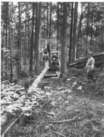
簡易作業路とバックホウによる木寄せ状況
