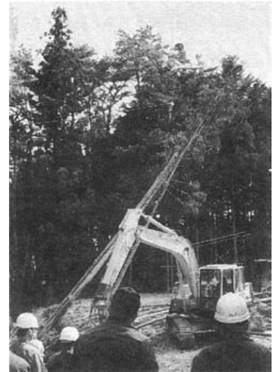
H型集材 上方は専用搬器「just 2」 下方はプロセッサ
