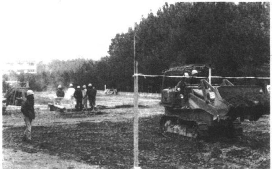
(車輛系建設機城の実技研修)
