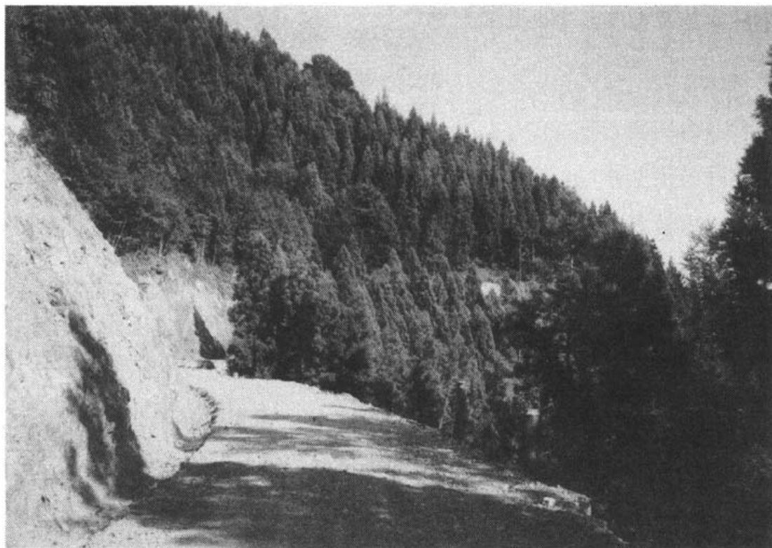
作業道の開設 — 海南町小川霧越作業道 —
