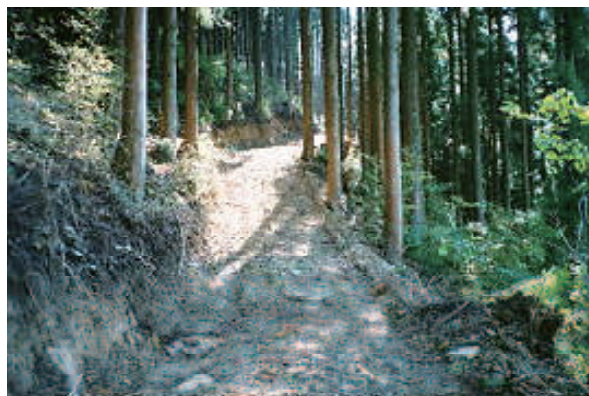
作業道の開設状況
