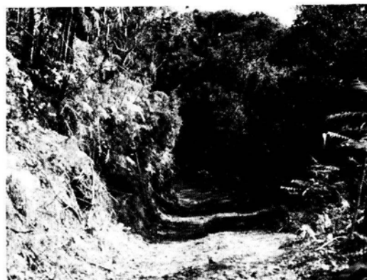
▲整備された簡易作業路と広葉樹林
