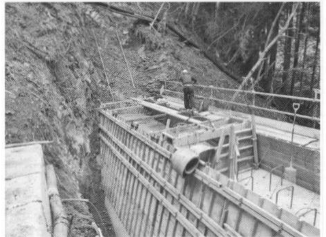
県産スギによるまく板型枠
