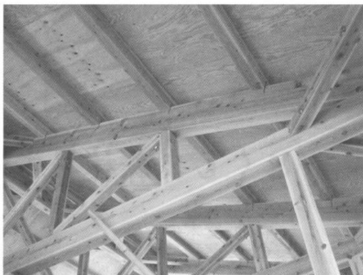
写真-1 木工事状況
