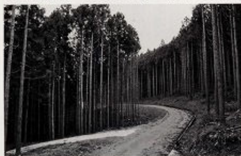
林業専用道（イメージ） 10tトラックの走行を想定した必要最小限の構造
