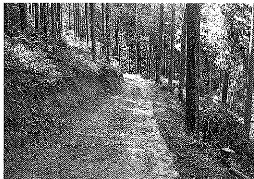
作業路開設状況
