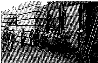
フル稼働する乾燥機
