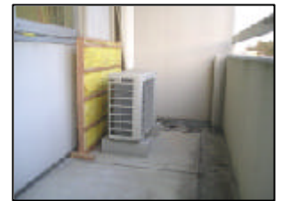
写真5 グラスウールによる吸音
