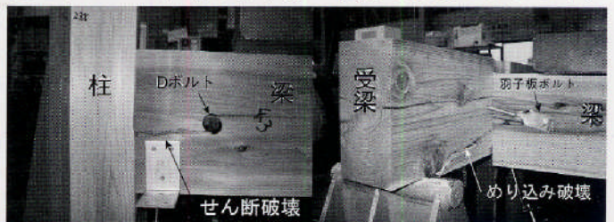
写真2 梁のせん断破壊と受梁のめり込み破壊
