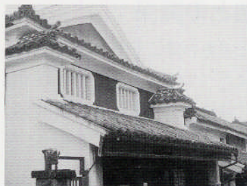
実測住宅外観(①邸)
