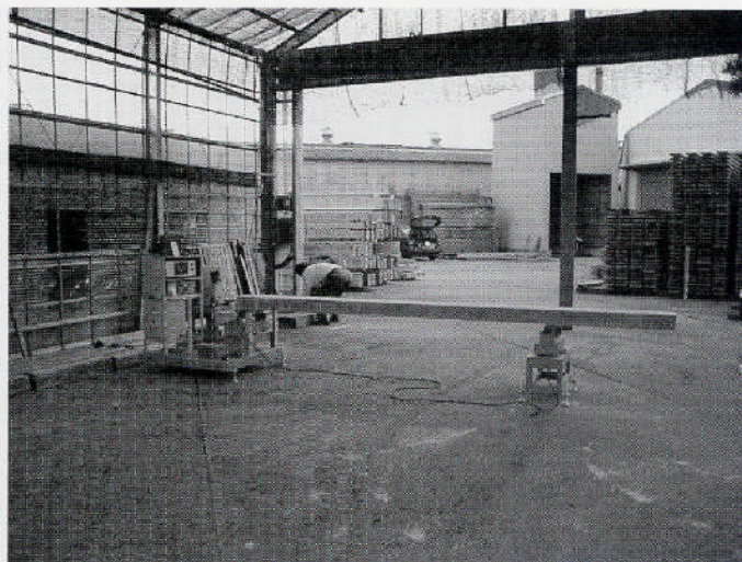
写真-3 測定材設置状況
