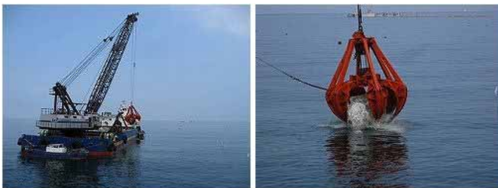
写真 1 鳴門市北灘町栗田地先における藻場造成工事の様子。台船で大きな自然石を投入します(平成 19 年 9 月 28 日撮影)。
