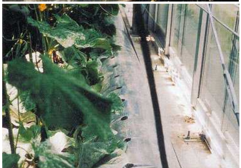
第3図 穴あけダクト(上)と施設内での設置状況(下)
