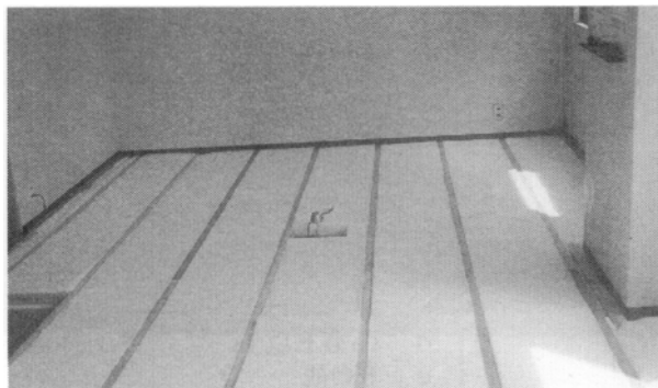
写真 2 - 2 吸音材施工
