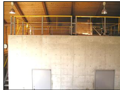
図－1 音響試験室の外観
