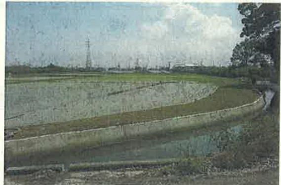
ライニングされた幹線用水路（麻名用水）
