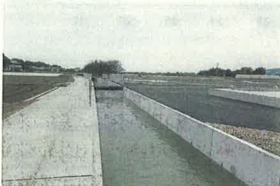
幹線水路（那賀川地区）
