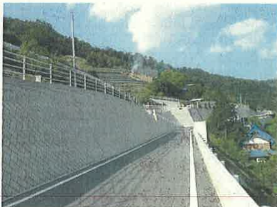
緊急輸送路を補完する農道
