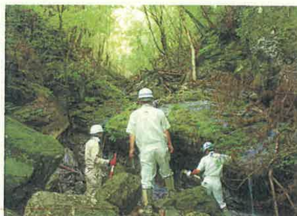
治山山地災害危険地区の点検
