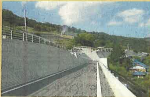
緊急輸送道路を補完する農道
