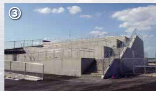
③ メガソーラーを一望できる展望台を設置(道路より5.7m高い)
