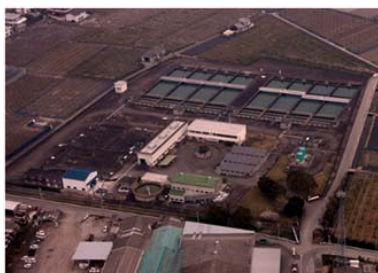
吉野川北岸工業用水道
