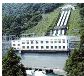
日野谷発電所
