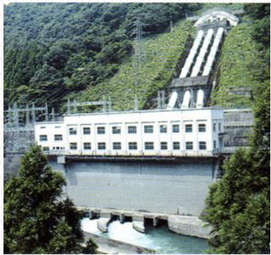
日野谷発電所
