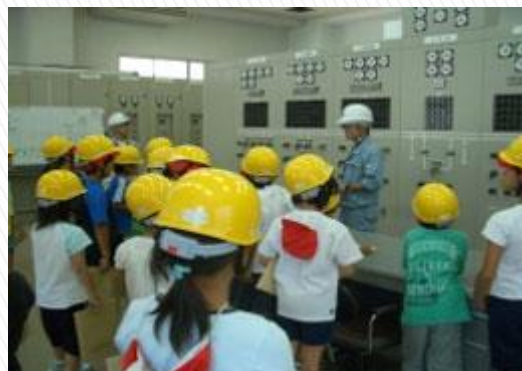
川口発電所の見学
