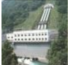
日野谷発電所
