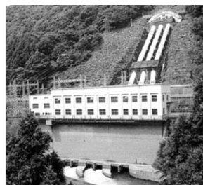
日野谷発電所
