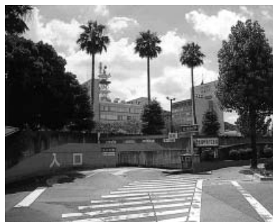
藍場町地下駐車場
