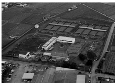
吉野川北岸工業用水道
