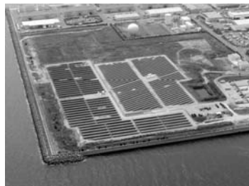
マリンピア沖洲太陽光発電所
