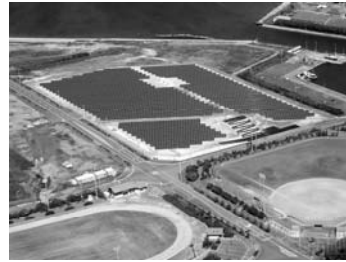
和田島太陽光発電所
