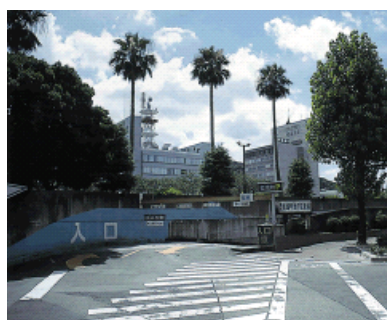
藍場町地下駐車場
