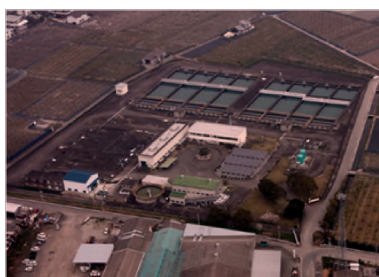
吉野川北岸工業用水道
