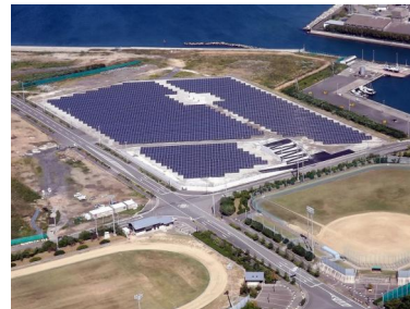
和田島太陽光発電所
