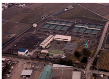
吉野川北岸工業用水道
