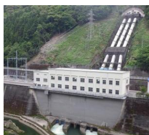
日野谷発電所
