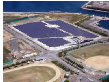
和田島太陽光発電所
