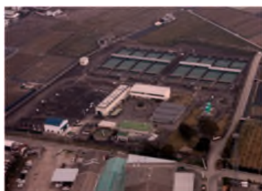
吉野川北岸工業用水道
