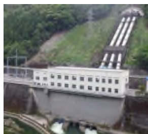
日野谷発電所
