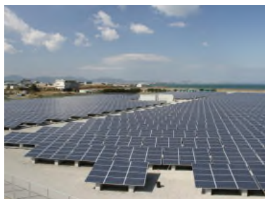
マリンピア沖洲太陽光発電所
