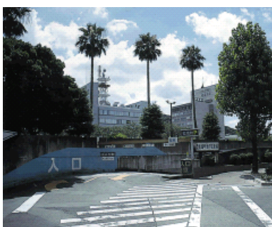
藍場町地下駐車場
