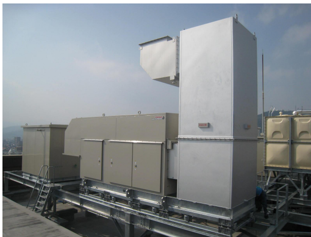
写真1 電源設備の屋上への移設
