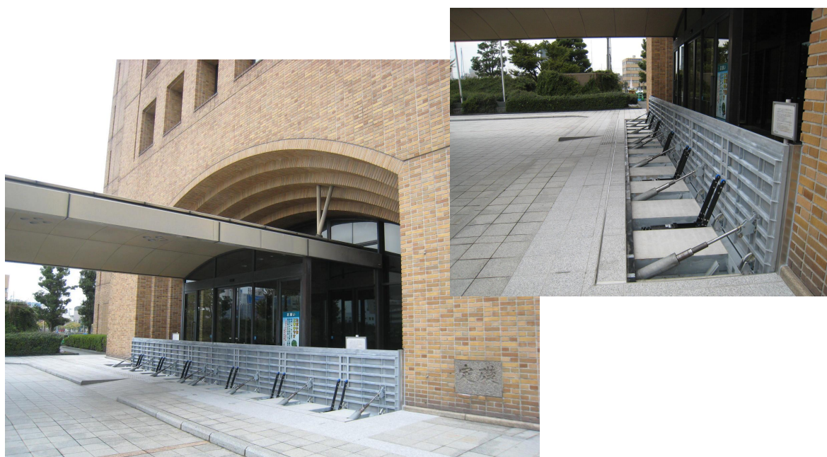
写真2 防潮パネルの設置（正面玄関）
