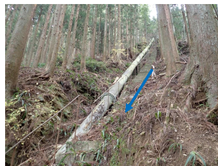
③旧水圧鉄管跡
