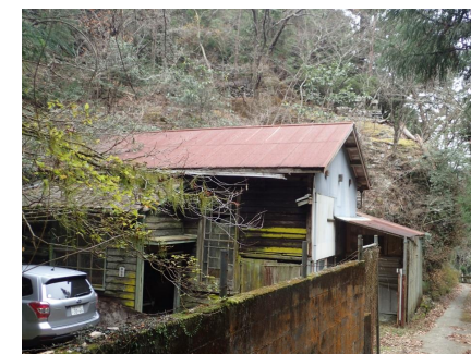
④旧発電所跡
