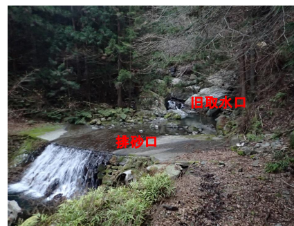
①取水堰の状況(左岸下流より)
