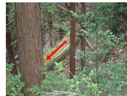
②旧導水路跡
