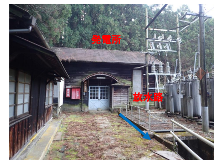
④旧発電所
