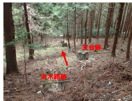
③旧水圧鉄管跡
