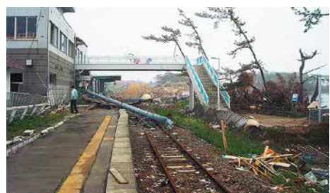
東日本大震災で被災したJR気仙沼線
