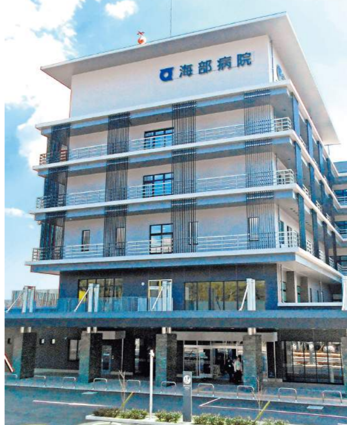
●新病院は、鉄筋コンクリート造6階建ての免震構造を採用しています。
