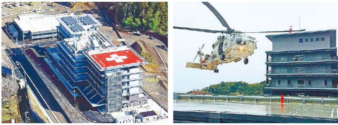
●病院棟と立体駐車場屋上の2箇所にヘリポートを設置。 ●災害時には、大型ヘリコプターにより大規模搬送が可能。
