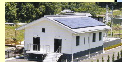
集落排水処理施設
