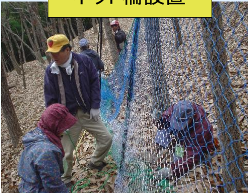
ネット柵設置
