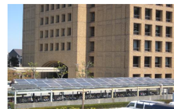
県庁駐輪場 太陽光パネル
