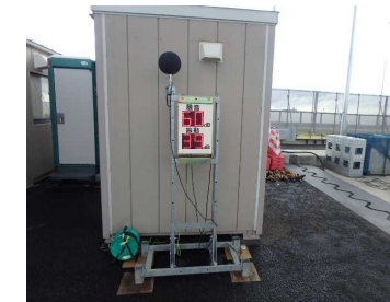
④自動騒音振動計測装置の写真
