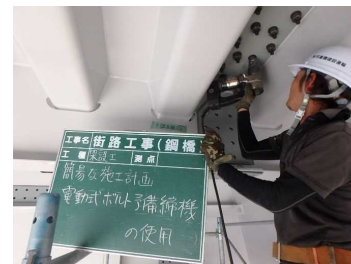
②騒音低減効果のあるボルト締付け機の写真
