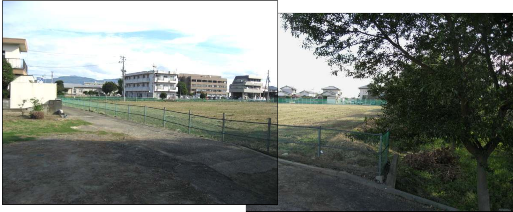
南西方向から
