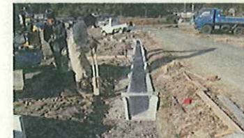
老朽化した水路の更新
