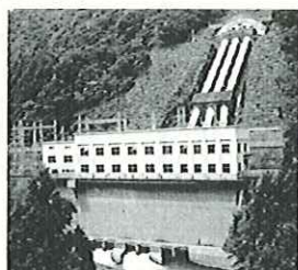
日野谷発電所
