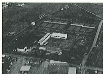
吉野川北岸工業用水道
