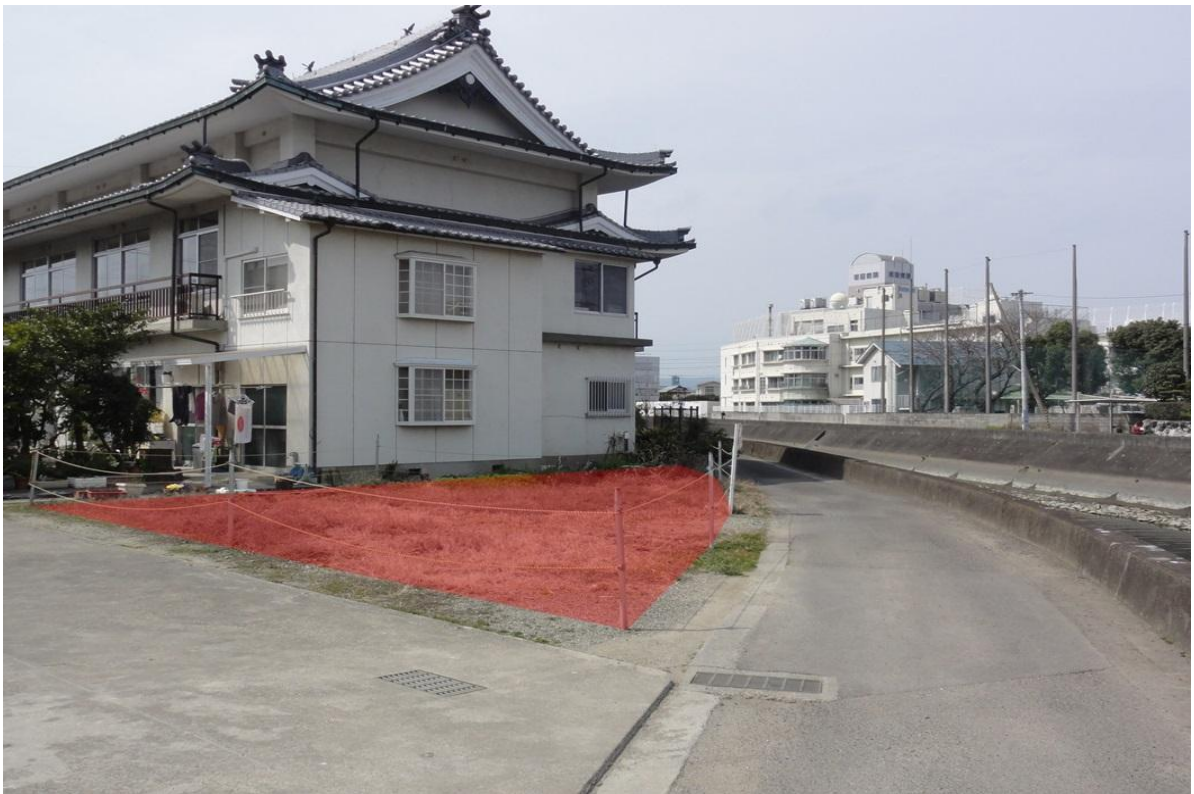
河川管理道路南方より対象不動産を望む
