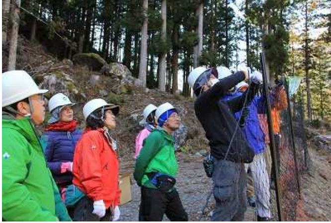
続いて支柱にネットを留めていきます
