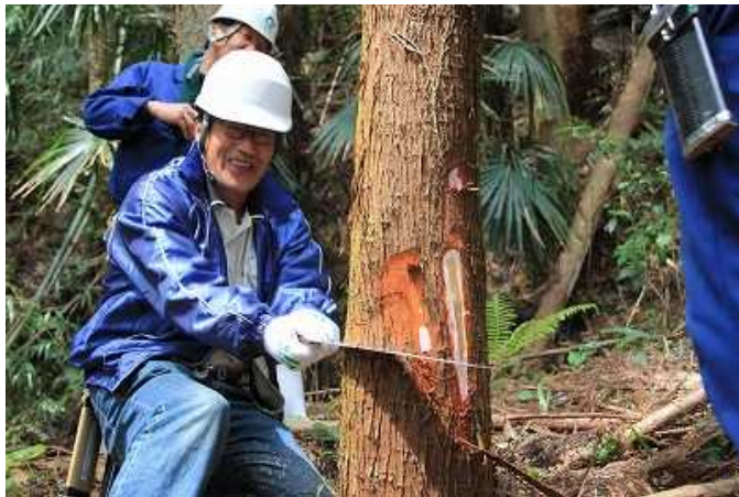
安全を確認しながらノコを入れていきます。
