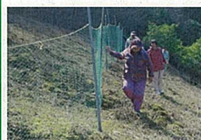
侵入防止柵の点検・メンテナンス (強化月間の取組み)
